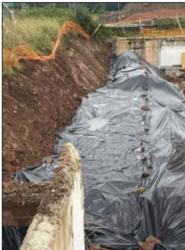
Fotografía 2. Acopio de materiales excavados debidamente tapados y sobre solera de hormigón.
