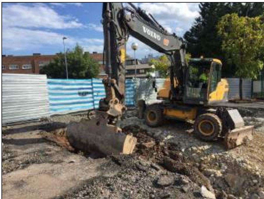
Fotografía 13. Sobreexcavación de la rampa para futuro acceso por presencia de PAH y arsénico.
