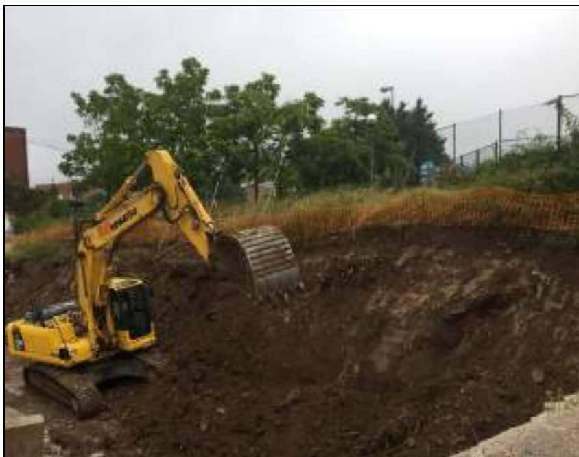
Fotografía 1. Excavación jardines situados en el extremo Este.
