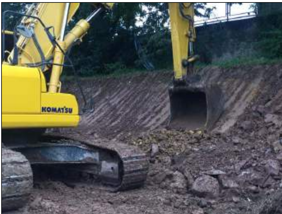
Fotografía 3. Excavación jardines del extremo Sur
