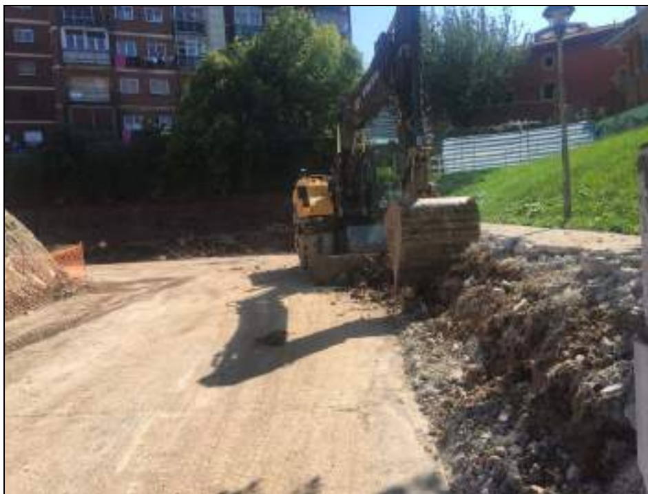
Fotografía 5. Excavación del nuevo muro Oeste
