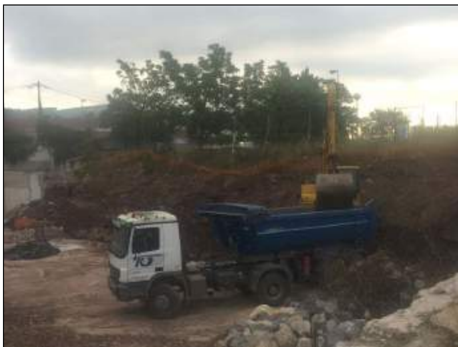
Fotografía 4. Carga de material al camión desde el acopio.
