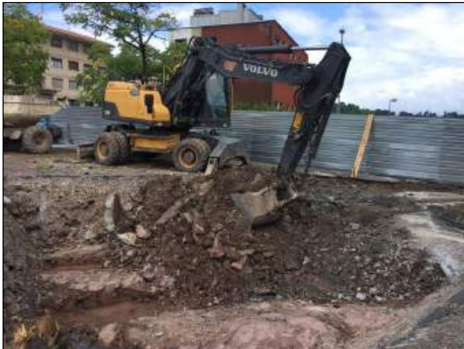
Fotografía 6. Excavación rampa para futuro acceso (extremo Este)
