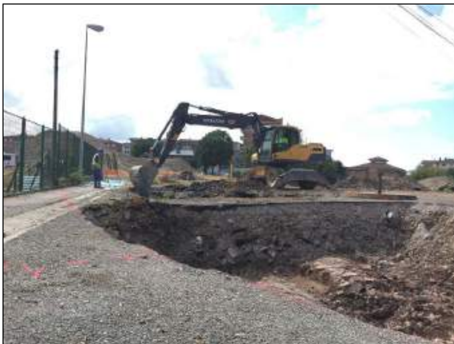
Fotografía 7. Excavación rampa para futuro acceso (extremo Este) respetando la conducción de agua
