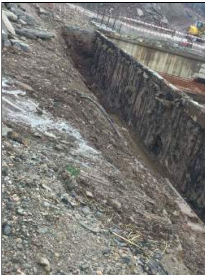
Fotografía 15. Trasdós muro sur excavado
