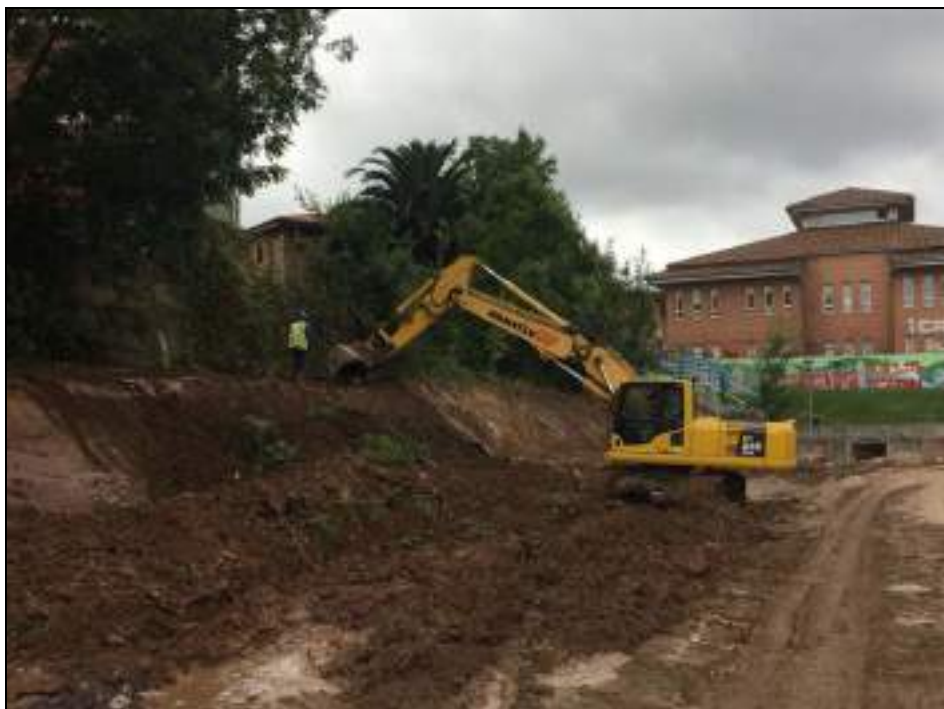
Fotografía 9. Sobreexcavación de parte de los jardines del extremo Sur
