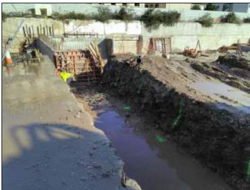
Fotografía 16. Trasdós muro sur excavado
