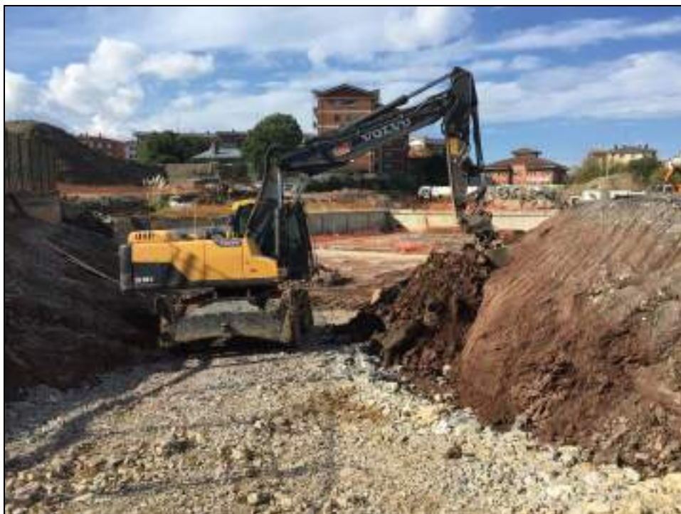
Fotografía 14. Sobreexcavación de la rampa para futuro acceso por presencia de PAH y arsénico.
