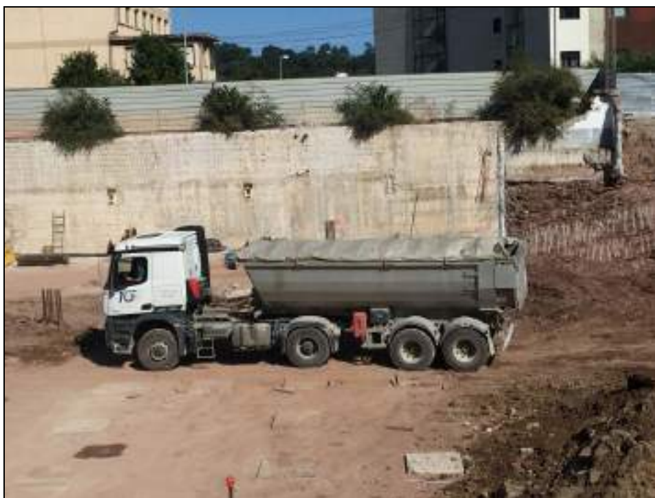
Fotografía 8. Traslado mediante camión bañera con caja estanca y cubierto con toldo impermeable
