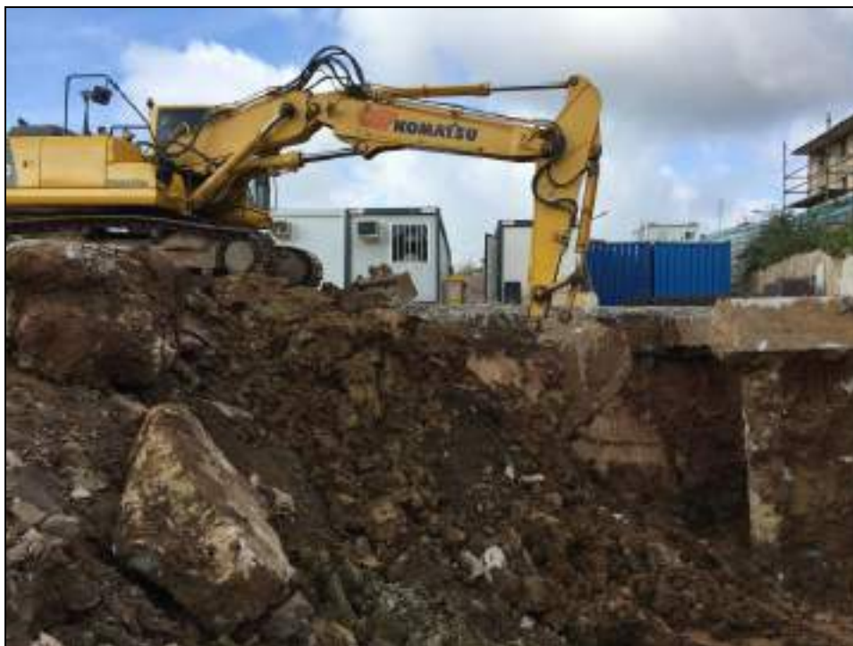
Fotografía 11. Excavación hueco zona central
