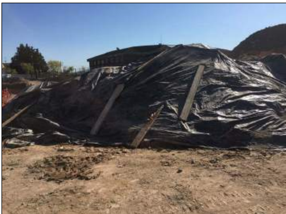
Fotografía 12. Acopio tapado mediante plástico y solera de hormigón (se observa tierra por el trasiego de maquinaria).
